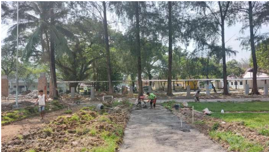
Pekerjaan Lantai Kerja Bata Ekspose
