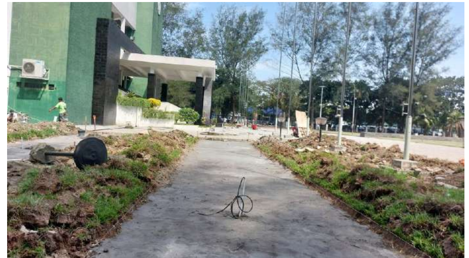
Pekerjaan Lantai Kerja Bata Ekspose
