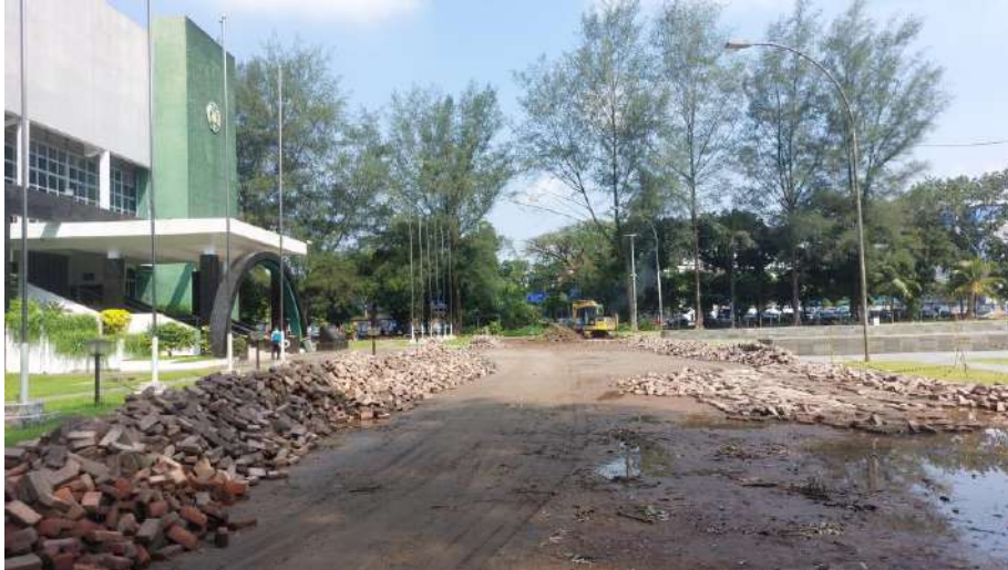
Penggalian Paving Block Utara
