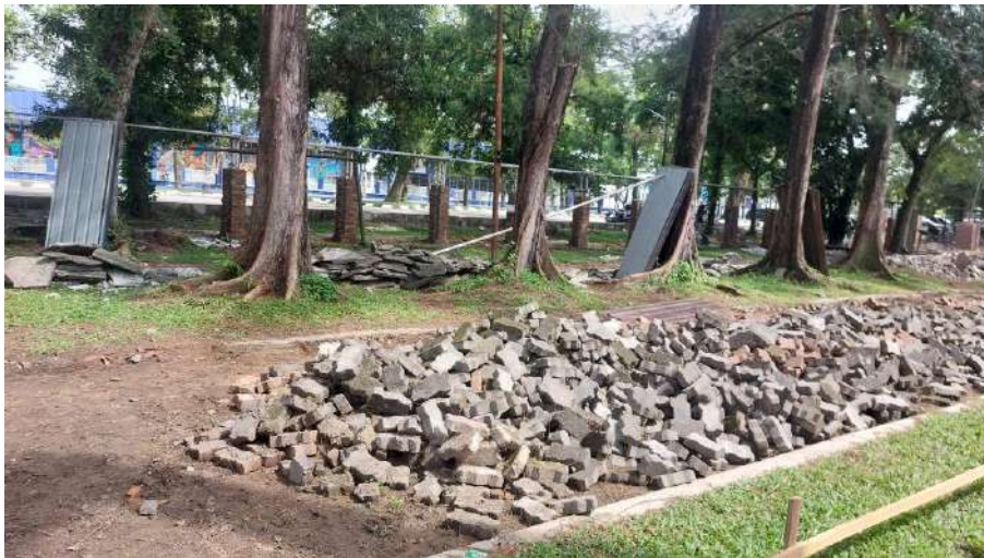
Penggalian Paving Block Joging Track Utara
