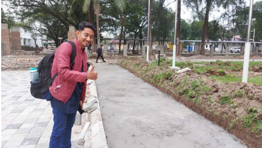
Pekerjaan Lantai Kerja Bata Ekspose
