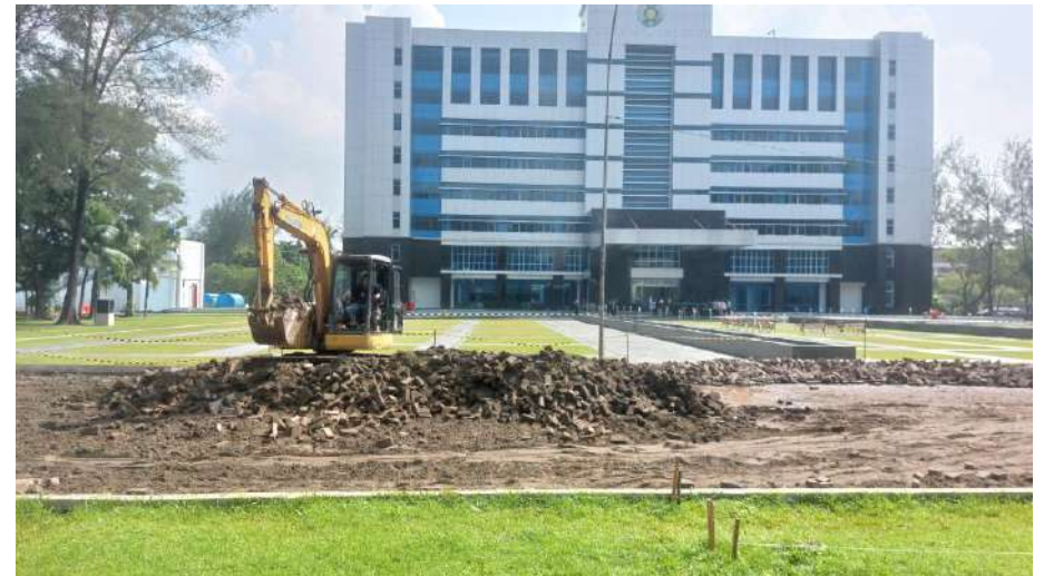
Penggalian Paving Block Utara Menggunakan Excavator
