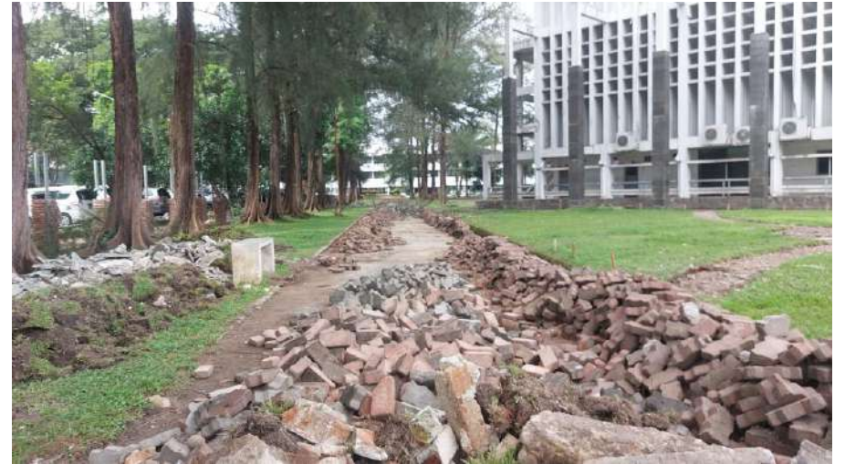
Penggalian Paving Block Joging Track Utara
