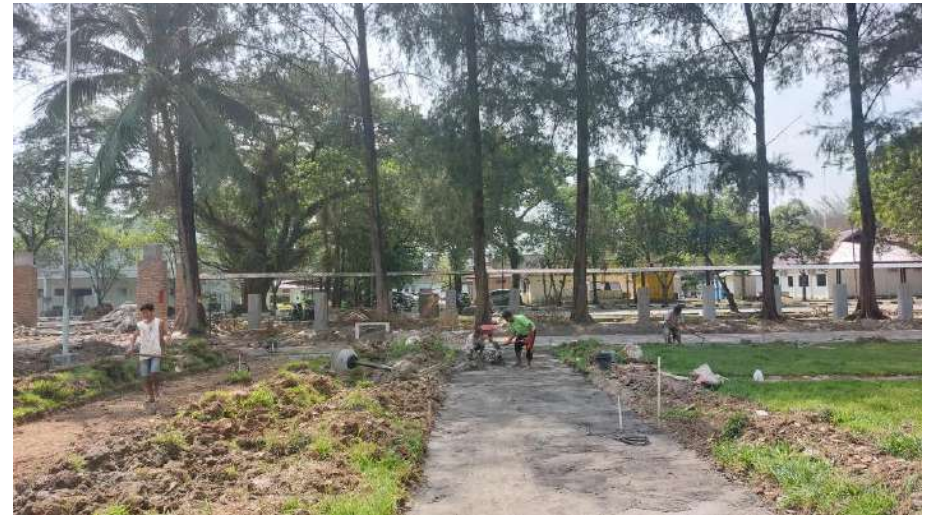
Pekerjaan Lantai Kerja Bata Ekspose
